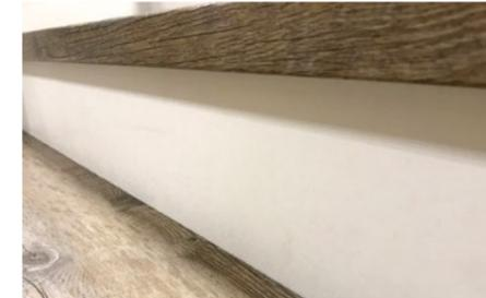
Setzstufen aus 2 mm PVC mit einer leicht strukturierten Oberfläche.
