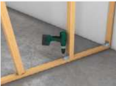
Montage der Holzständer mit Stiftnagel oder Stahlwinkel
