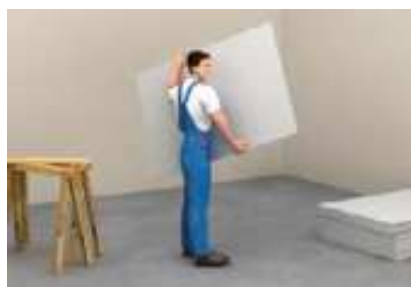
Einzelne fermacell® Gipsfaserplatten hochkant tragen
