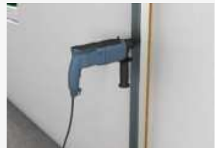
Befestigung der CW-Profile an Massiwand auf Dämmstreifen
