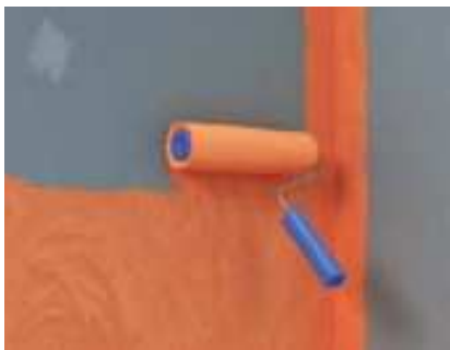
Abb. 7: Sicherstellung der Abdichtung für die Wassereinwirkungsklasse W1-I und W2-I. fermacell™ Flüssigfolie mit der Rolle mind. 2 x vollflächig auftragen (Trockenschichtdicke mindestens 0,5mm). Gemäß DIN 18534-3 wird für den 2. Auftrag ein Farbunterschied zur besseren Nachvollziehbarkeit gefordert. 1. Auftrag: fermacell™ Flüssigfolie in Originalfarbe satt auftragen und trocknen lassen
