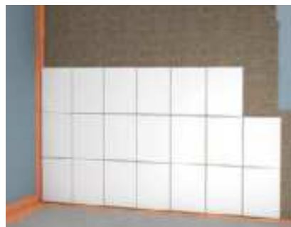
Abb. 6: Sicherstellung der Abdichtung für die Wassereinwirkungsklasse W0-I. Verfliesung mit fermacell™ Flexkleber im Dünnbettverfahren
