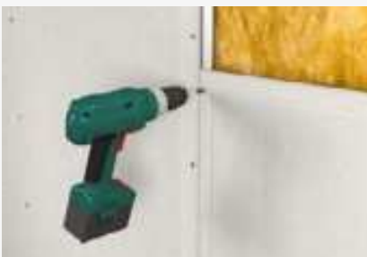
Schrauben auf Stahlunterkonstruktion
