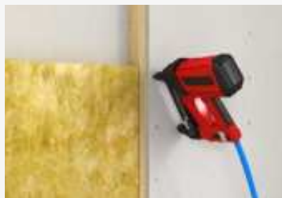
Klammern auf Holzunterkonstruktion
