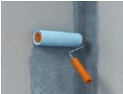
Abb. 1: Vollflächiges Aufbringen des fermacell™ Tiefengrunds – Trocknungszeit mind. 2 Stunden - Mischungsverhältnis: 1:1 bis 1:2 mit Wasser
