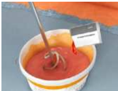
Abb. 8: 2. Auftrag: Farbkonzentrat zur Restmenge der Flüssigfolie geben und homogen einrühren. Eingefärbte Flüssigfolie satt auftragen. Weitere Informationen sind im Produktdatenblatt zu finden. Es ist empfehlenswert, den zweiten Anstrich quer zum Ersten aufzutragen, um evtl. Fehlstellen in der Abdichtungsschicht zu vermeiden.
