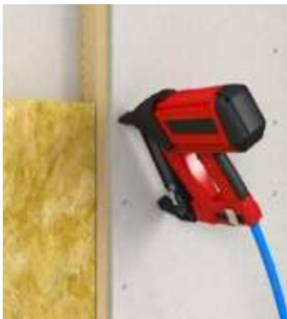
Bekleidung der Holzunterkonstruktion mit Klammern
