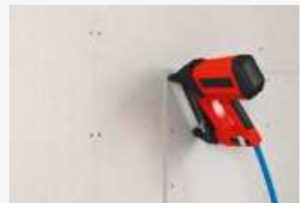
Klammern fermacell® Gipsfaserplatte auf fermacell® Gipsfaserplatte (unterkonstruktionsneutral)
