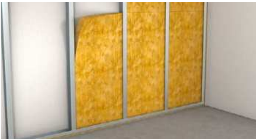
Einbringen der Dämmstoff-Platten
