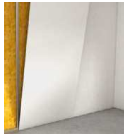
Bekleidung der Metallunterkonstruktion
