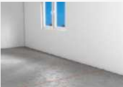
Anlegen der Wandachse mit Schnurschlag oder Hochbaulaser
