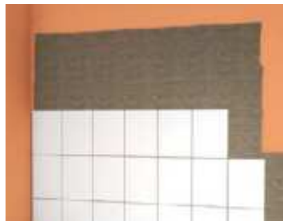
Abb. 9: Verfliesung mit fermacell™ Flexkleber im Dünnbettverfahren auf vollflächiger Abdichtung
