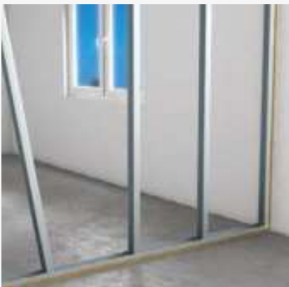
Montage der CW-Ständerprofile
